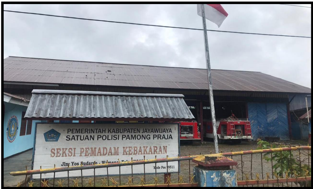
Tampak Depan : Kantor Sementara Dinas Satuan Polisi Pamong Praja Kabupaten Jayawijaya yang mana awalnya merupakan Kantor Pemadam Kebakaran Kabupaten Jayawijaya
